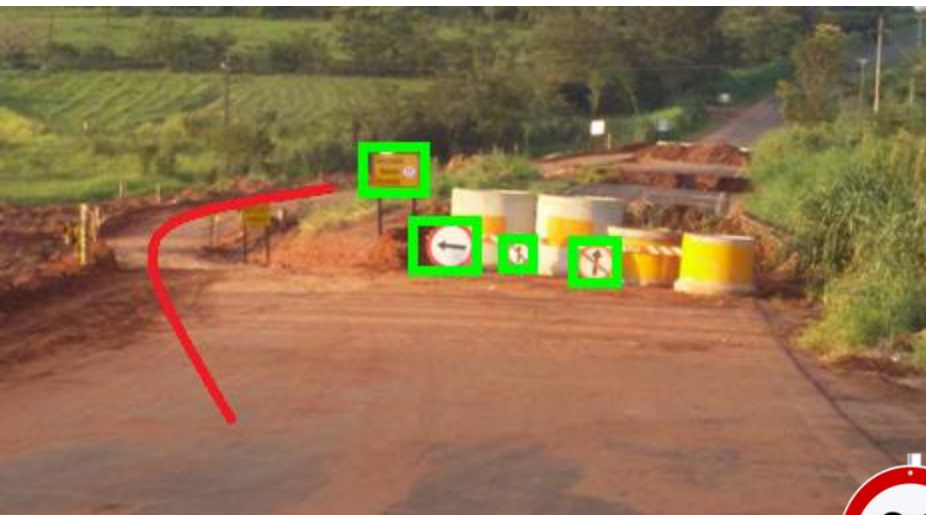
Desvios: Rota auxiliar
